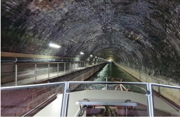
Tunnel de Saint-Maur
